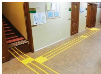
Специальные объемные тактильные плитки и другие варианты напольных покрытий (например, встраиваемые направляющие полосы и биты) формируют рисунок, позволяющий незрячим людям получать информацию о безопасном пути движения (направления движения, повороты) и о наличии препятствий на пути движения (пороги, перекрестки, ступени, лестницы, столбы или колонны, двери, пешеходные или подземные переходы).
