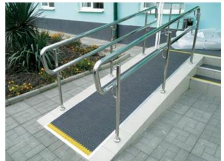
Стационарные пандусы подразделяются на однопролётные либо двухпролётные, имеющие переходную горизонтальную площадку.
